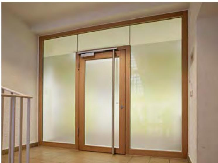
Die Eingangstür wird nur durch das 21 mm starke F30-Brandschutzglas gehalten. Es besteht aus mehreren Schichten und enthält Brandschutzgel, das im Fall eines Feuers aufschäumt.
