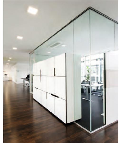
Raumhohe Glastrennwände mit integrierten Schließfächern. Außen (r.) Paneele mit Schallabsorberfunktion.
