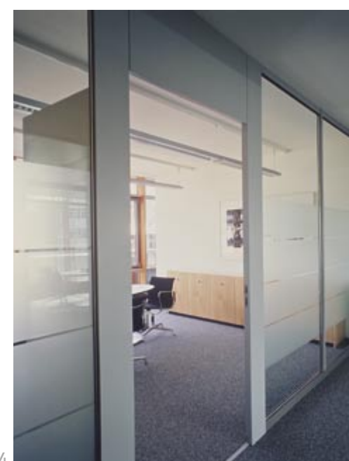
Detailansichten: die Basiskonstruktion des Ständerwandsystems K-2000
