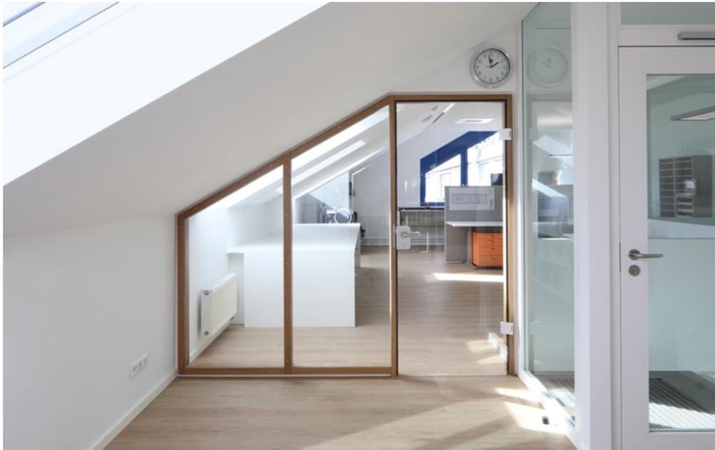
Die Bereichstrennung mit Holz-Glas-Element (Eiche) und T30RS-Treppenselement (RAL 9016 lackiert).
