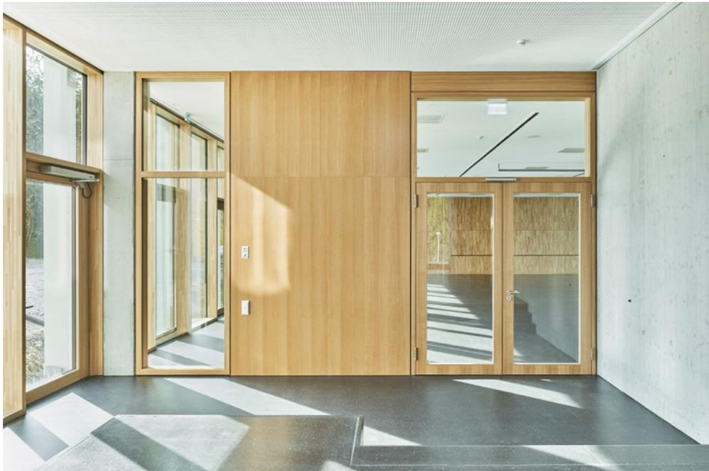
Multifunktional & ästhetisch: das zweiflügelige T30RS-Türelement mit Panikfunktion als Zugang zur Mensa, eingebettet in eine Wandverkleidung (Eiche) mit Festverglasung F-30.
