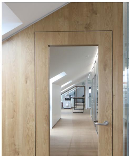
Der Flurabschluss mit flächenbündigem Türelement.
