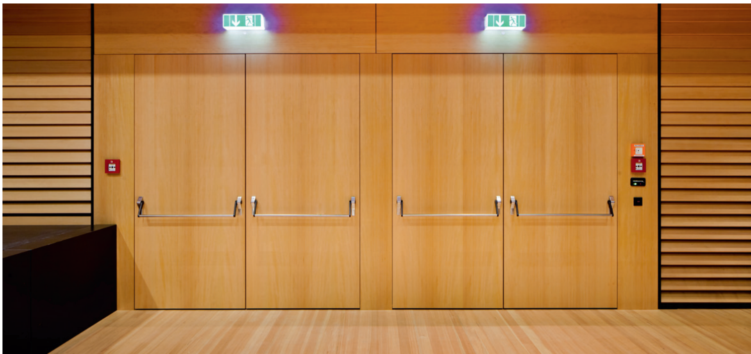
Überzeugen in Design und Funktionalität: Die Türen des Konzertsaals hat ZEEB stark schallgedämmt und gekonnt flächenbündig ausgeführt. Panikstangen sichern den Fluchtweg.
