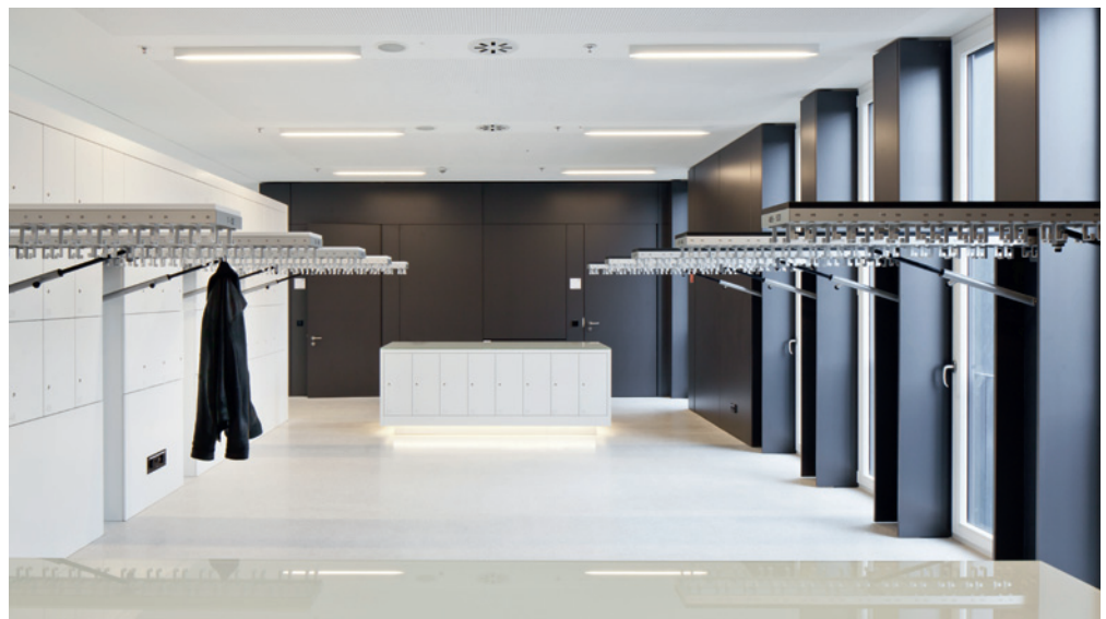
Aufgeklappte Garderobenmodule im Multimediakomplex der Karlsruher Musikhochschule: Zusätzlich hat ZEEB hier zahlreiche Schließfächer sowie zwei Garderobentische mit Glasoberseite integriert.
