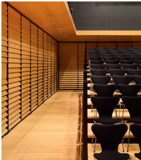
Lüftungslamellen an den Wänden des Wolfgang-Rihm-Forums: akustisch hochwirksam und optisch ansprechend.
