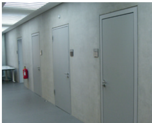
Schlicht und anspruchsvoll: Türelemente im Sichtbeton.
