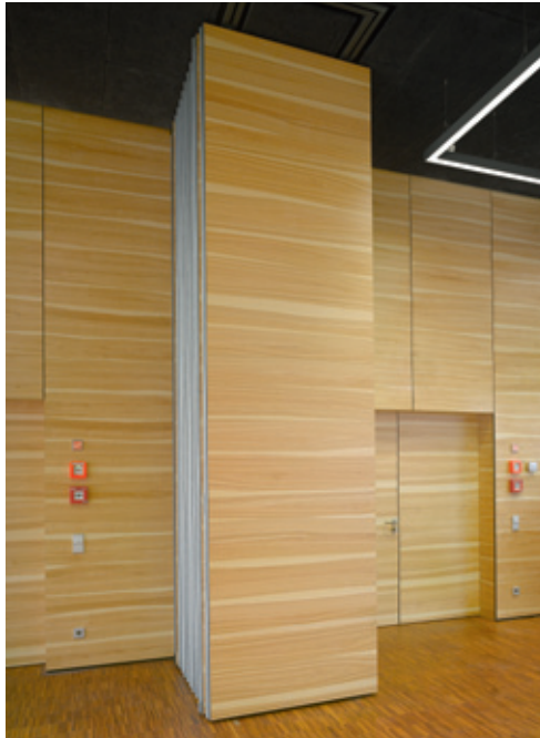
Die furnierte mobile Trennwand im „geparkten“ Zustand.
